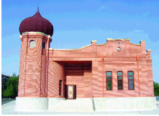
Zaviye-Medrese Binası (XVII-XVIII. asırlar)
